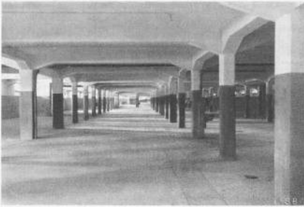
Abb. 8. Vermietbare Lagerräume im Untergeschoss der Empfangshalle.
