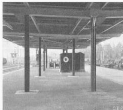
Abb. 12. Gedeckte Rampe mit Annahmestelle.
