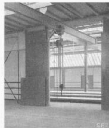
Abb. 13. Laufkran in der Empfangshalle.
